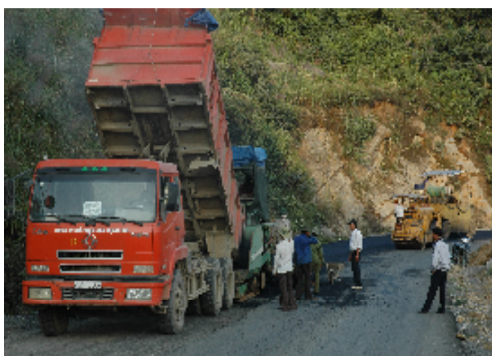
Thi công rải thảm nhựa gói thầu số 4 QL 279
