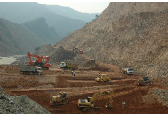
Thi công đắp đập thủy điện Bản Chát
