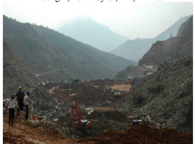
Thi công kênh dẫn dòng thủy điện Bản Chát
