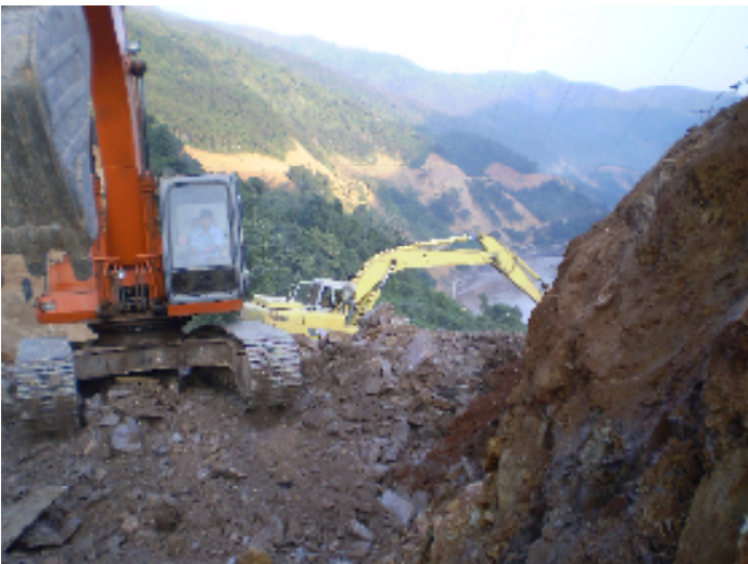
Thi công hạ nền QL 279
