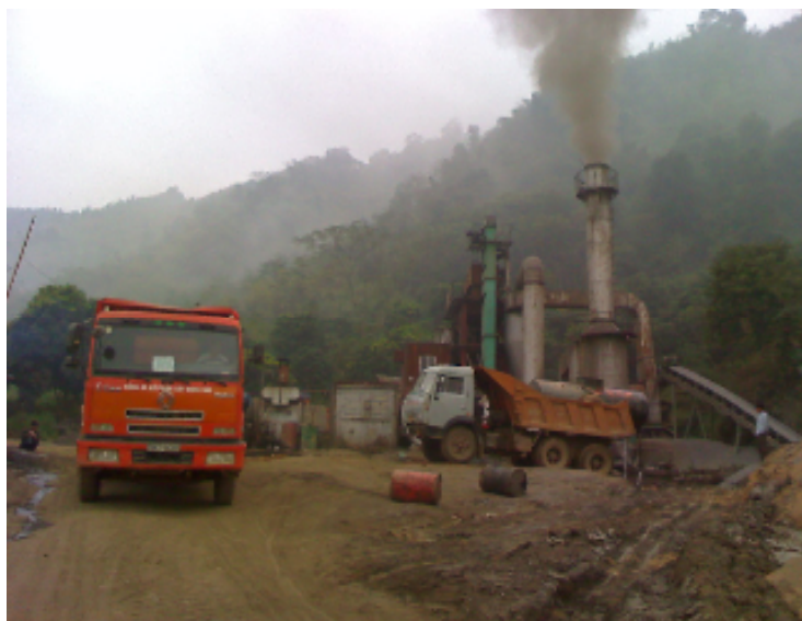
Trạm trộn bê tông nhựa nóng 80 tấn/h
