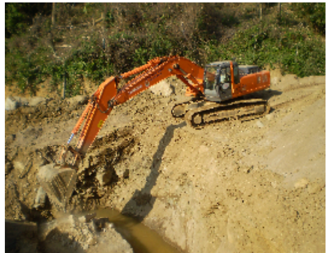
Thi công hạ nền thủy điện Nậm Khốt
