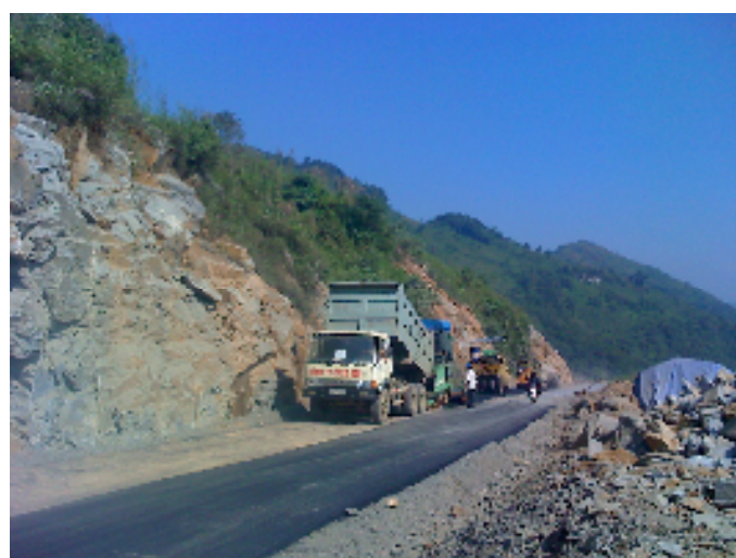
Thi công rải thảm nhựa gói thầu số 6 QL 279
